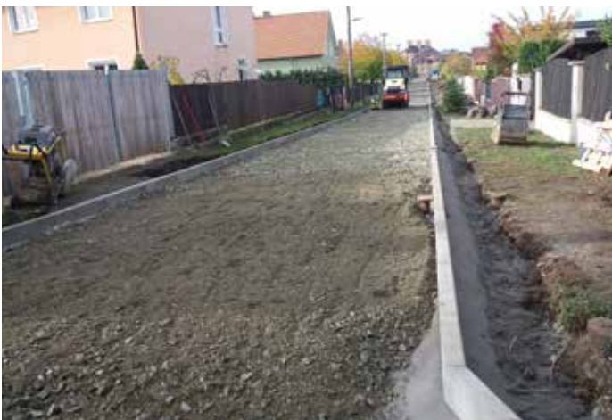
Komunikace v průběhu realizace, foto P. Příšovská
